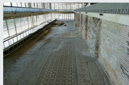
Edificiul roman cu mozaic – interior, înainte de refacere
