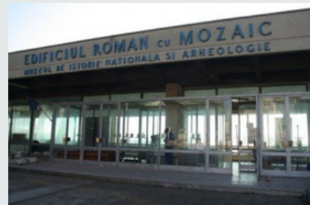
Edificiul roman cu mozaic – exterior, înainte de refacere
